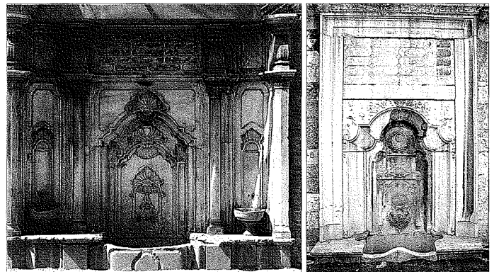
Davutpaşa Haznedar Usta Çeşmesi ile Zevkî Kadın Çeşmesi
